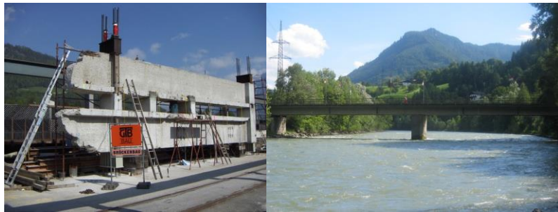
Abbildung 1: Salzachbrücke in „Werfen“, links: Versuchsbaufbau, rechts: Brücke im ehemaligen Zustand
